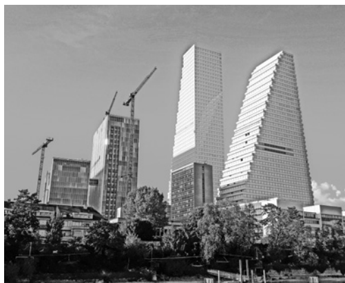
Gebäude der F. Hoffmann-La Roche AG in Basel (Foto: VdW)
