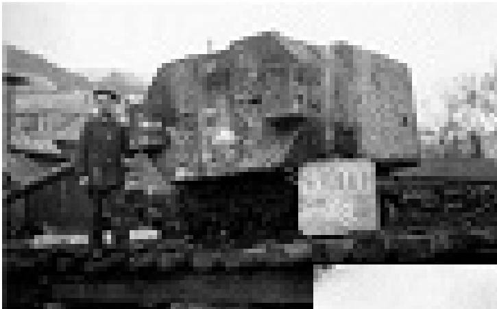
In den Frank'schen Eisenwerken gegossene Schabotte für den Reddighäuser Hammer, daneben Emil Hils als Gussputzer, um 1904 (Bild: Hessisches Wirtschaftsarchiv)
